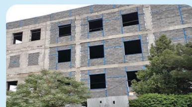
اجرای دیوارهای پیرامونی طبقات
