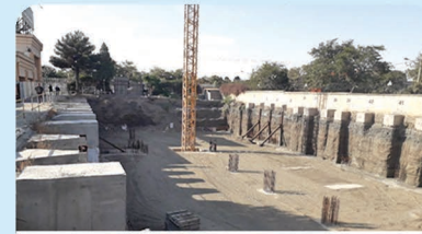
تسطیح و رگلاژ سطوح خاکبرداری شده
