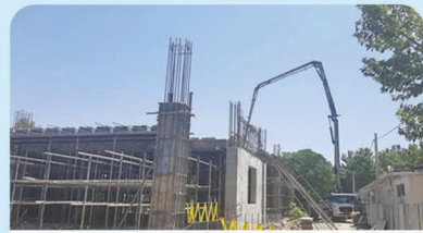
قالب بندی آرماتور بندی و بتن ریزی سقف دوم
