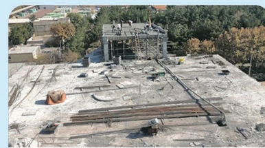
قالب بندی، آرماتور بندی و بتن ریزی سقف خرپشته
