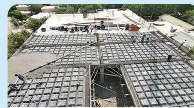
قالب بندی آرماتور بندی و بتن ریزی سقف چهارم
