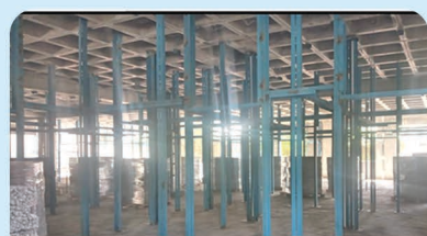
اجرای والپست های دیوارهای داخلی طبقه همکف
