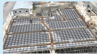
اجرای قالب بندی و آرماتور بندی سقف اول
