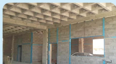
اجرای دیوار چینی دیوارهای داخلی طبقه همکف
