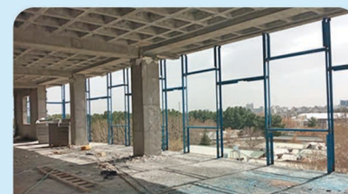
اجرای والپست دیوارهای خارجی
