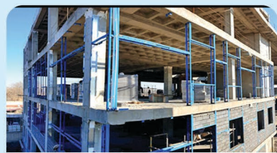
اجرای والپست دیوارهای خارجی
