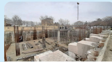
اجرای قالب بندی و آرماتور بندی المانهای عمودی طبقه
