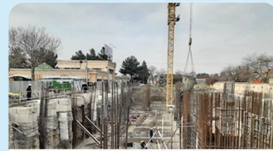
اجرای آرماتور بندی و بتن ریزی المانهای عمودی طبقه
