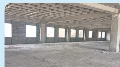
اجرای دیوارهای پیرامونی طبقات
