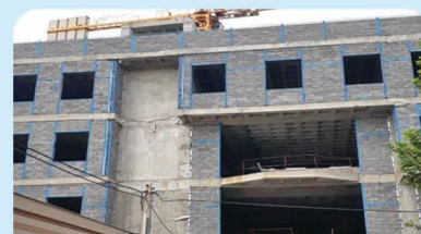
اجرای دیوارهای پیرامونی طبقات
